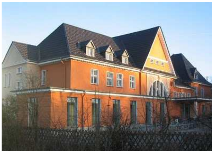
(Foto: BEG, Empfangsgebäude Lünen)
