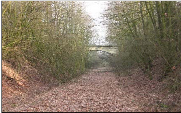
2008 [Quelle: ARGE RW / ST-Freiraum]
