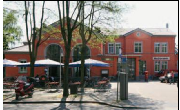
Empfangsgebäude nach Sanierung [Quelle: BEG]
