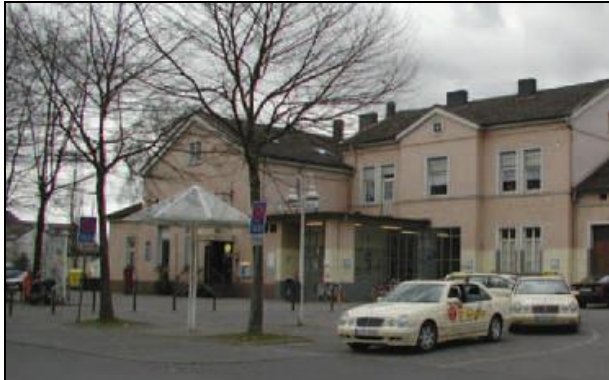
historische Aufnahme des Empfangsgebäudes
