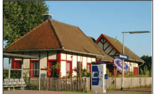
Empfangsgebäude nach Sanierung [Quelle: BEG]
