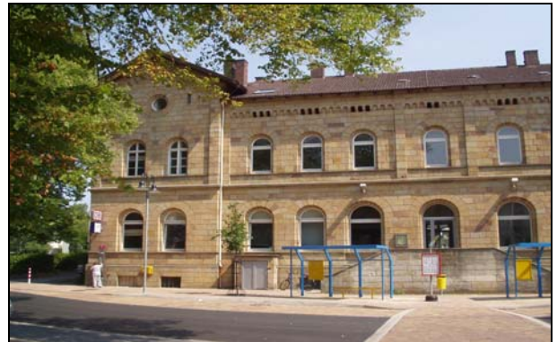
Empfangsgebäude nach der Sanierung
