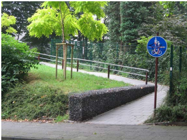
Beispiel für einen befahrba- ren Zugang zum Radweg (Korkenzieherbahn)
