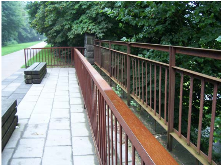
Absicherung des historischen Geländers durch ein stabiles, zurückgesetztes Brückengeländer (Korkenzieherbahn)
