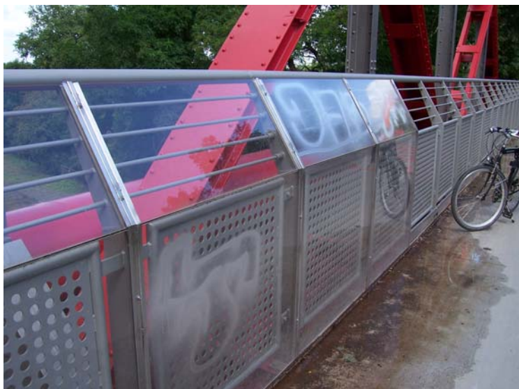
Beispiel für ein erhöhtes Brückengeländer mit Plexiglasschutz (ErlebnisTrasse Erzbahn)
