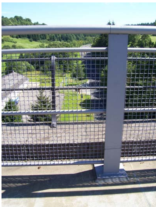
Absicherung des historischen Geländers durch ein höheres, zurückgesetztes Brückengeländer (Maare-Mosel-Radweg)
