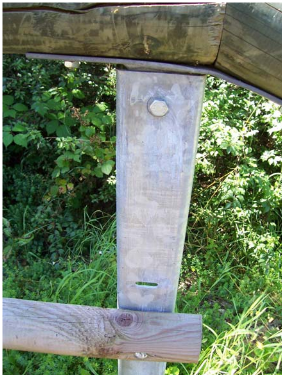
Detailansicht einer Verbindung von Stahlpfosten mit Holzquerträger (Maare-Mosel-Radweg)
