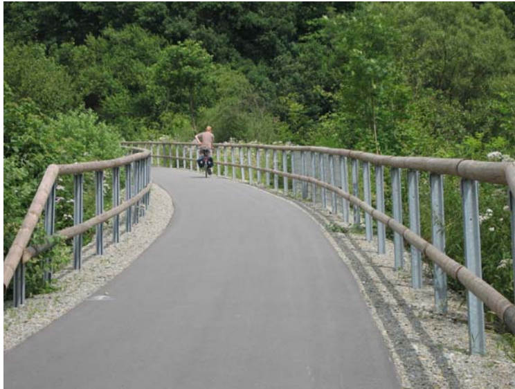
Absturzsicherung aus Stahlpfosten mit Holzquerträger (SauerlandRadrिंग)
