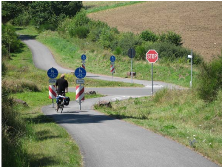
Beispiel für eine S-Kurve zur Temporeduktion vor einer Querungsstelle (Maare-Mosel-Radweg)
