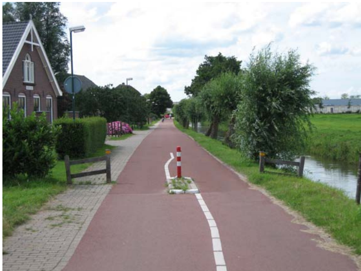
Beispiel für einen Absperrpfosten mit einleitender Markierung (Houten, Niederlande)
