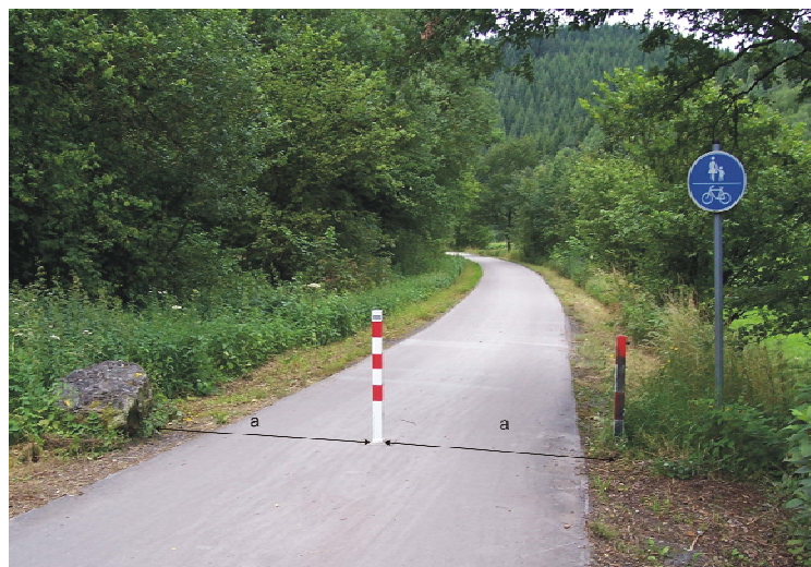
Beispiel für einen mittleren Absperrpfosten. Ein seitlicher Pfosten ist durch einen Stein ersetzt.
